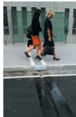
Fig. 1 : Détail du joint de trottoir. À droite : habillage de la bordure.
